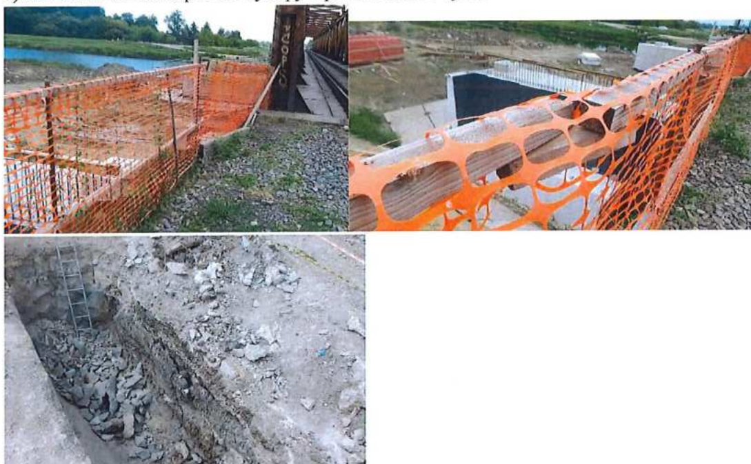
c) Nedostatočne zabezpečené výkopy a pracoviská vo výške
